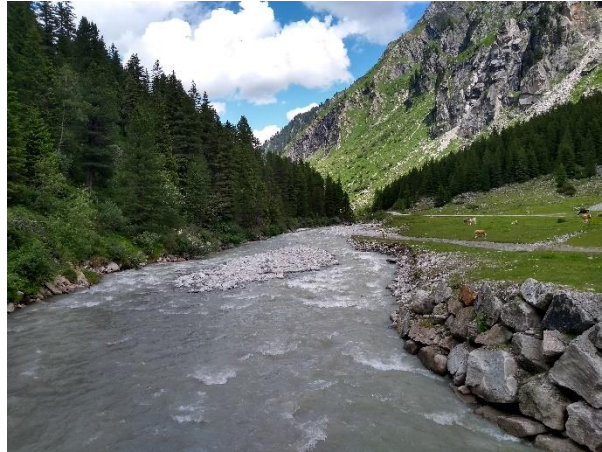
Abbildung 4-7: Bereich Schiedhofalm; Wirtschaftsbrücke und modellierter Abschnitt flussauf und flussab der Brücke
