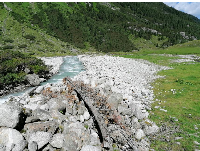
Laufbegradigung und Dammschüttungen am Obersulzbach im Bereich Postalm, dadurch Verringerung der Geschiebepufferfunktion
