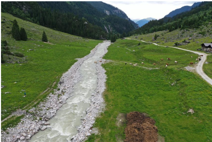
Laufbegradigung und Dammschüttungen am Obersulzbach im Bereich Foißenalm, dadurch Verringerung der Geschiebepufferfunktion;
