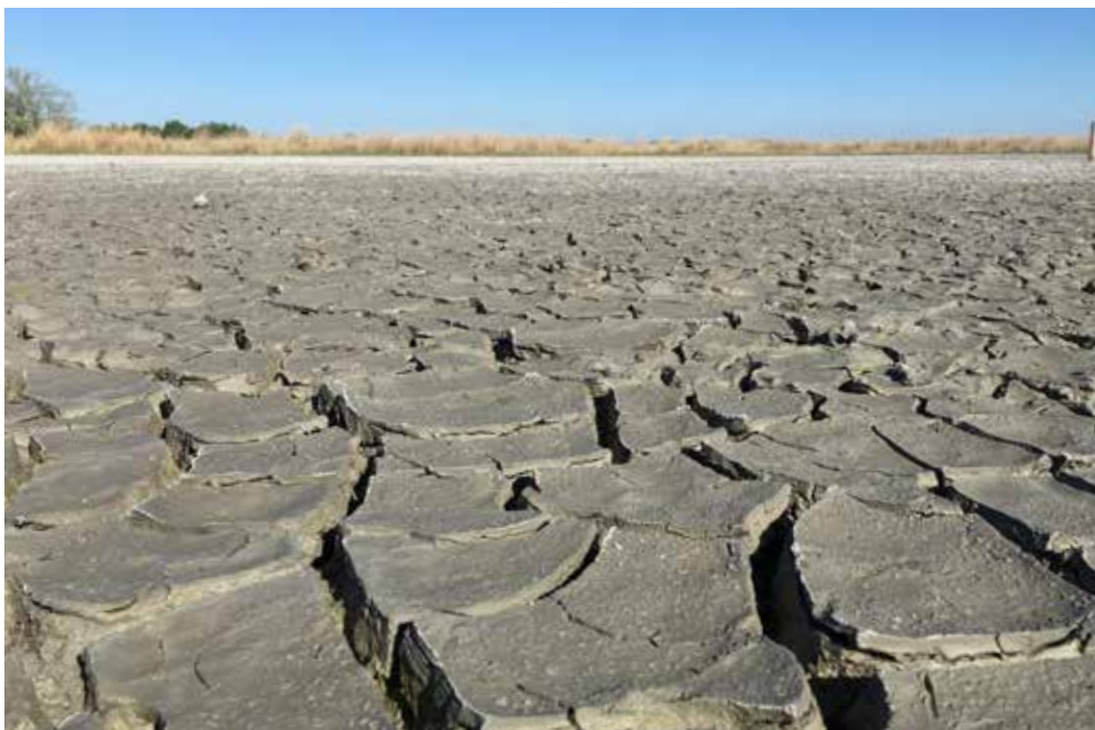
Abbildung 16: Das durch den hohen Salzgehalt bedingte Quellen und Schrumpfen ist am Lackenboden der Illmitzer Zicklacke deutlich zu erkennen.
