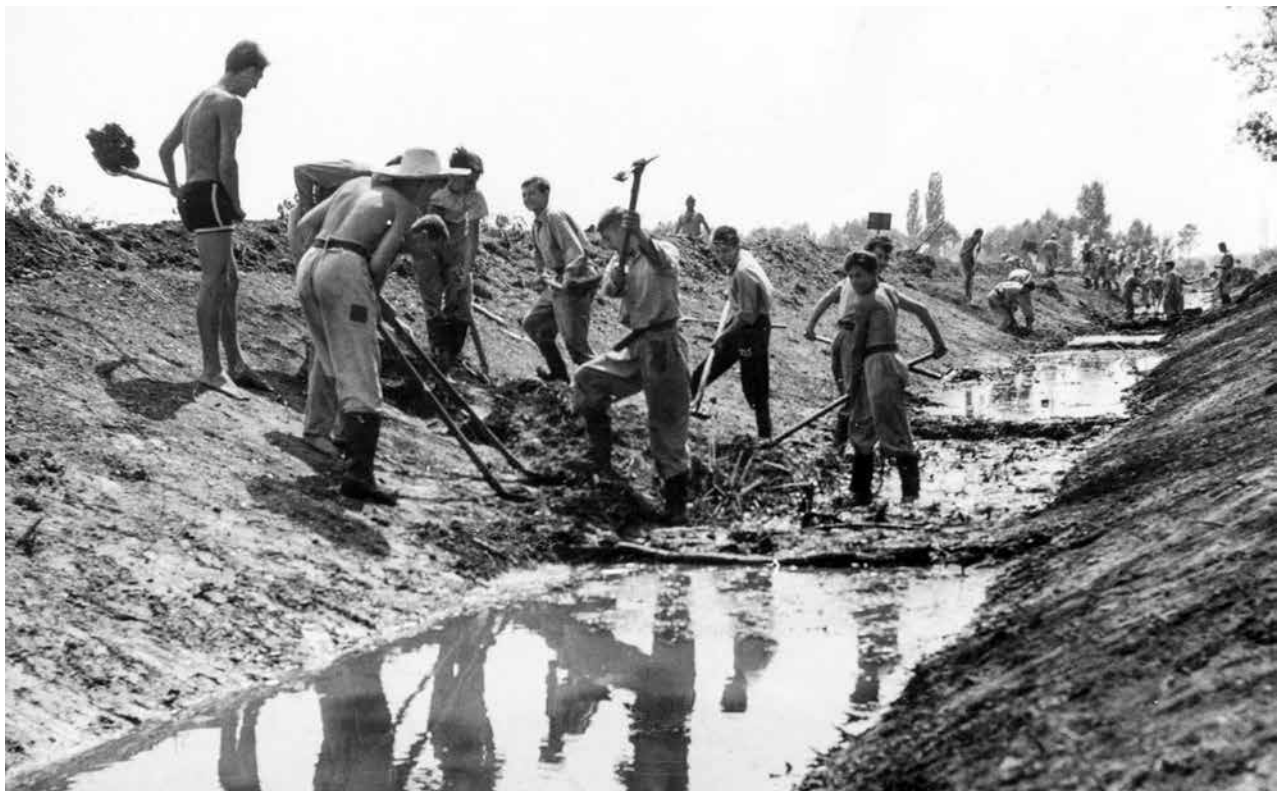
Abbildung 19: Vom Einserkanal (ung.: Hauptkanal) bis zum kleinsten Entwässerungsgraben fielen früher permanent händische Arbeiten an, welche den benötigten Durchfluss garantierten, wie hier im Hanság.
