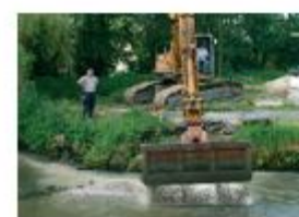
Abb. 6: Hydraulische Anpassung mit Bühnen, Umlagerung von Kies & Kieszugabe (aus Pulg 2007)
